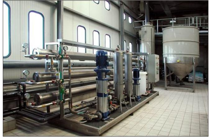
Cuando hay ya un sistema químico-físico que "trabaja" bien y no es posible hacer la separación previa de las descargas en función de su carga contaminante, es posible ahorrar hasta el 60-70% del agua aplicando un sistema de osmosis inversa sobre las aguas depuradas químicamente.
