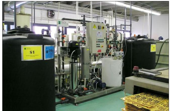
Cuando las concentraciones de contaminantes y la salinidad de los lavados son muy bajas, es posible alcanzar con solo una fase de osmosis inversa unas proporciones de concentraciones elevadas, mientras que las descargas de concentrado pueden enviarse directamente, o previa reducción con evaporador, al gestor externo, con un alto porcentaje de recuperaciones de agua superior al 90%.
