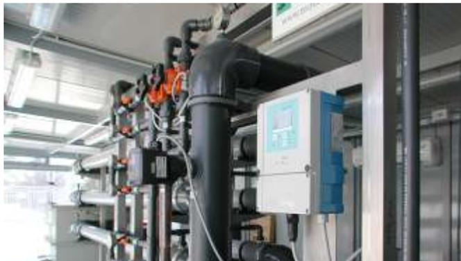
Gli impianti TECN.A. MBR (Membrane BioReactor) sostituiscono il tradizionale decantatore con un sistema di separazione a membrane di ultrafiltrazione.
