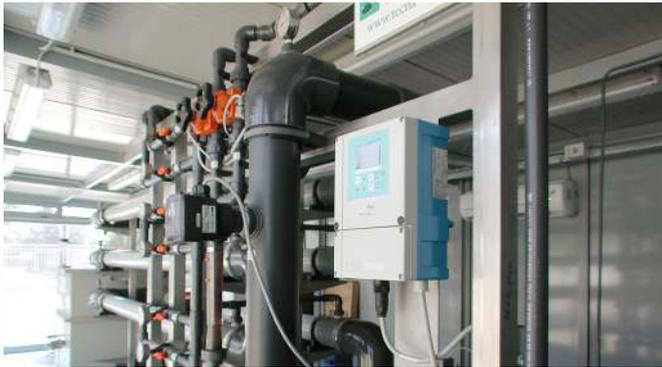
Los sistemas TECN.A. MBR (Membranas BioReactor) sustituyen al decantador tradicional con un sistema de separación con membranas de ultrafiltración.
