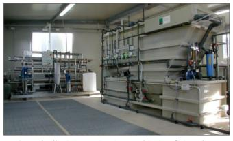
Quando l'esistente impianto chimico-fisico diventa insufficiente per il trattamento di tutti gli scarichi e quando è possibile eseguire una loro separazione, si può installare un impianto di osmosi inversa su una parte dello scarico per il suo riciclo.
