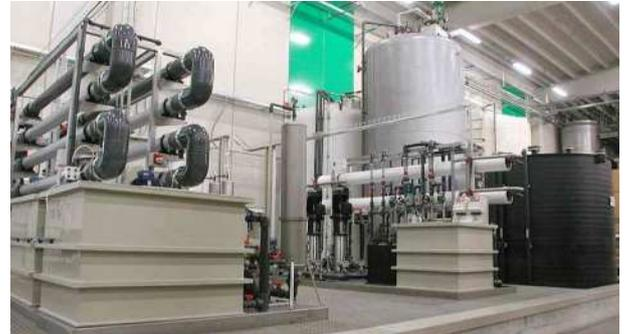
Nanofiltrazione con pretrattamento di Ultrafiltrazione
