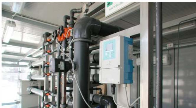
Les implantations TECN.A. MBR (Membrane BioReactor) remplacent les traditionnels décanteurs par un système de séparation à membrane d'ultrafiltration.
